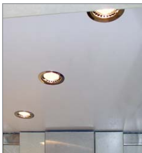
Illuminazione standard con tre faretti. Lighting with spots light.
